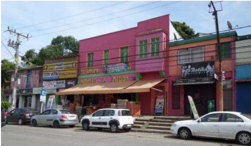
Comercio en el eje de avenidas Pedro Montt – José Manuel Balmaceda. Se aprecia el uso del espacio público como extensión de los locales comerciales y la inadecuación de las aceras a la circulación de discapacitados.
