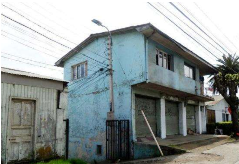
Construcción de dos pisos (comercial el primero y habitacional el segundo) en Avda. Centenario, acera nor-poniente.
