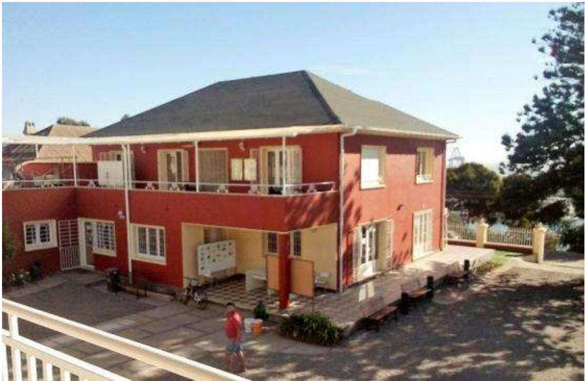
Equipamiento en la acera oriente de Avda. 21 de Mayo: en la foto superior, cuartel de la PDI. Abajo, sede universitaria
