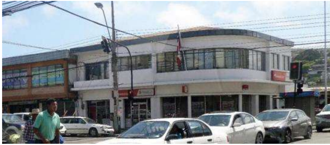
Esquina de Avda. Centenario y calle Lauro Barros. Edificio de correos e Chile, ilustrativo de la tipología arquitectónica del centro en las décadas de 1950 y 1960.
