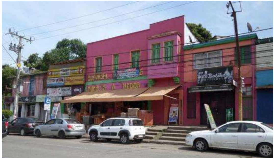
Borde de la sub-zona: acera norte de Avenida Balmaceda. Además de la precariedad de la construcción se advierte el uso de la vía pública como extensión del comercio y la ausencia total de facilidades para la accesibilidad universal.
